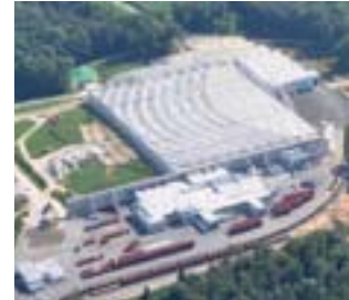
Luftbild des Sanierungsstandortes Bonfol
