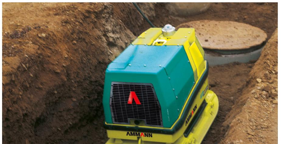
« Avec la commande à distance, le modèle APH 1000 TC permet de travailler depuis un endroit sûr – aucun danger et aucune vibration au niveau des bras et des mains pour le conducteur d'engin.»
