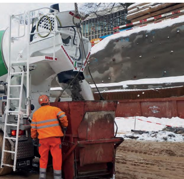
Erster Einsatztag: Einer der beiden elektrifizierten Fahrmischer bei der Ablieferung von Beton auf einer Baustelle.
