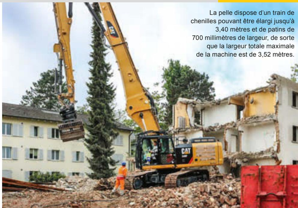
La pelle dispose d'un train de chenilles pouvant être élargi jusqu'à 3,40 mètres et de patins de 700 millimètres de largeur, de sorte que la largeur totale maximale de la machine est de 3,52 mètres.
