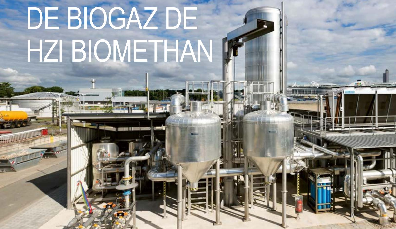
Grâce à ces installations compactes et performantes, les biogaz bruts sont traités de manière économe en tant que source d'énergie renouvelable de haute qualité, le biométhane, qui peut être alimenté dans le réseau de gaz naturel. Selon l'emplacement, les installations utilisent les procédés de lavage aux amines sans pression ou la technique membranaire.
