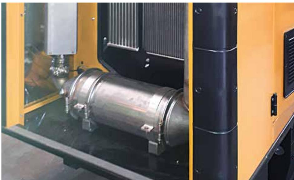
Gruppo elettrogeno con filtro CRT DPX2 e preriscaldamento elettrico.
