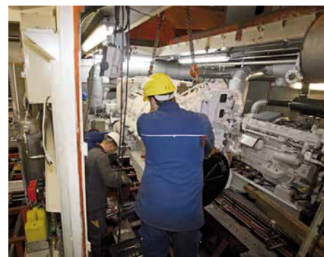
Montage du moteur Caterpillar 3,5 tonnes
