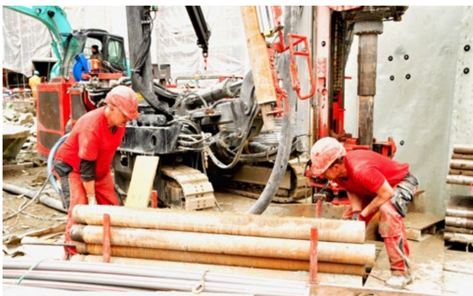
Teamwork: Bohrmeister Savo Dragojlovic von der Geowärme AG und sein Hilfsbohrmeister Bozo Tadic, Baustelle Zermatt, Avesco.
