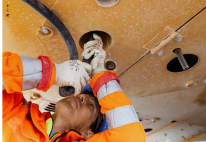
Der externe Wasseranschluss für die Berieselungsanlage wurde auf Wunsch anstelle eines Tanks eingebaut.
