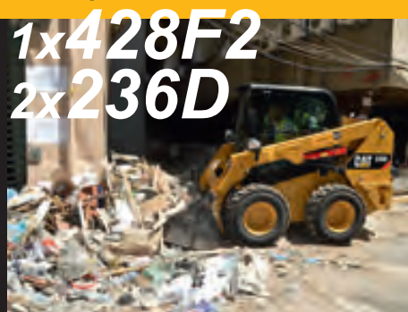
40 Mitarbeiter transportierten im Rahmen der Aufräumarbeiten 18 Muldenkipper voll Schutt ab.
