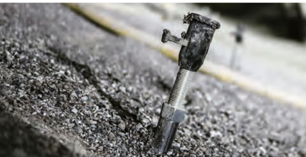
Un grand nombre de trous allant jusqu'à 10,3 mètres de profondeur sont percés dans les parois du tunnel. Ceux-ci seront compressés avec des gels acryliques ou de la résine au polyuréthane.
