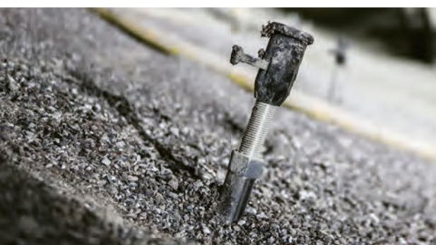
Nelle pareti della galleria sono eseguiti diversi fori con una profondità che va fino a 10 m. I fori sono compressi con gel acrilici o resine poliuretaniche.
