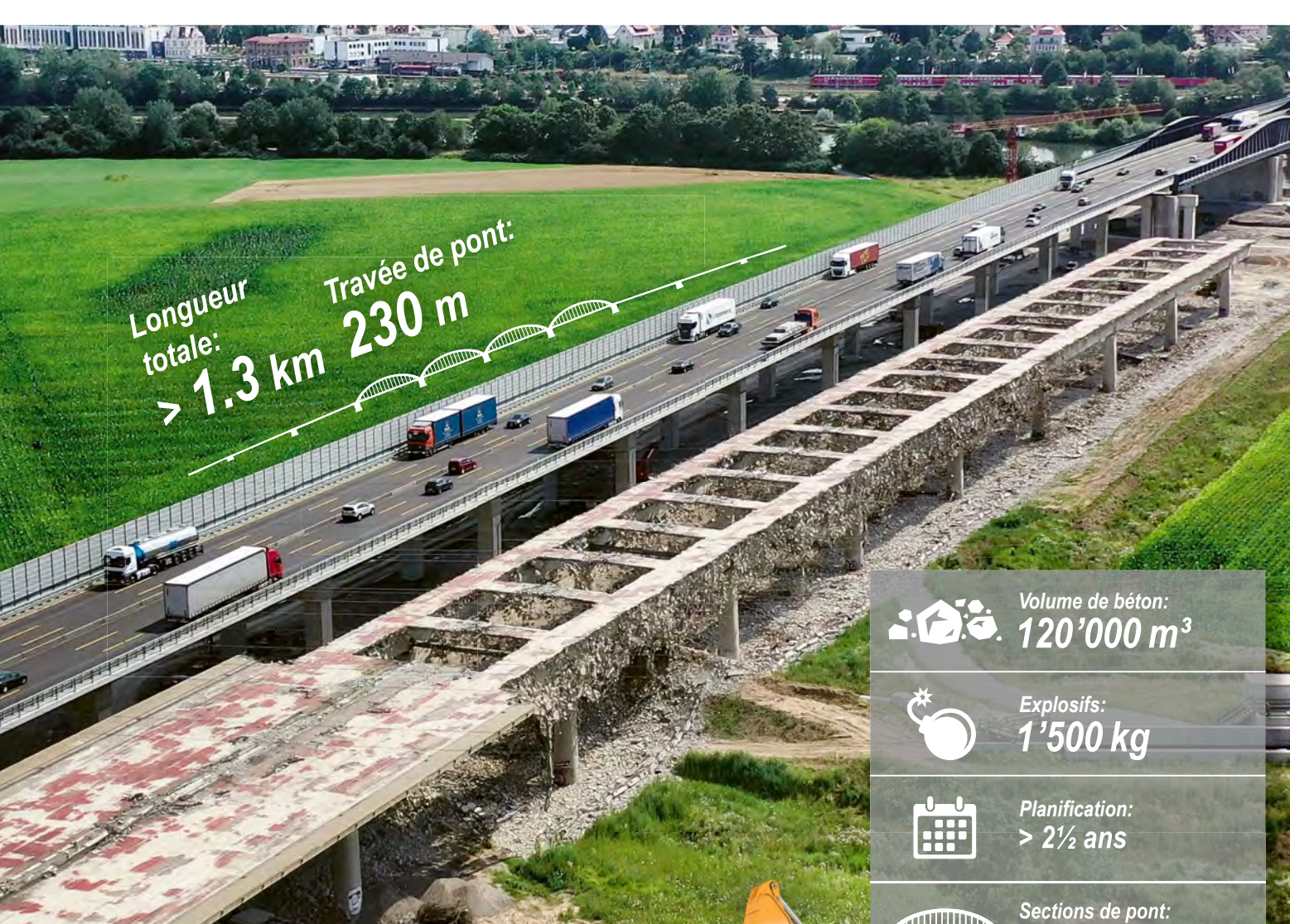
Démontage de la traversée de la vallée du Neckar entre les jonctions Neckarsulm et Untereisesheim dans le district de Heilbronn
