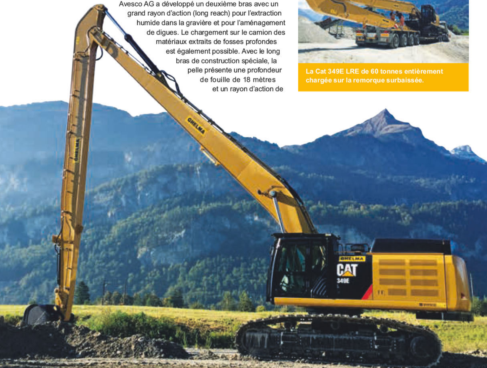
La Cat 349E avec l'équipement long-reach dans la gravière.
