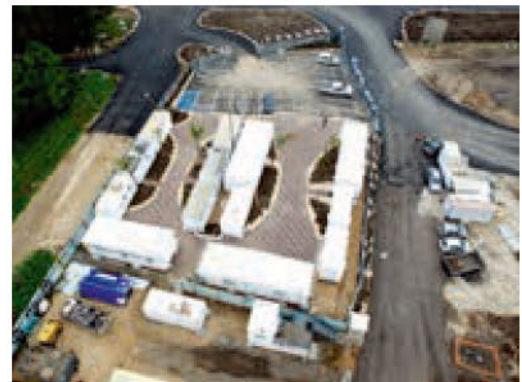
▼ La salle de contrôle d'EMSolutions dédiée sur le chantier assure le suivi de l'état des machines en temps réel.
