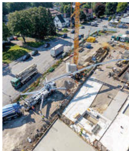
Geringe Aufstellfläche und dennoch enorm stabil: die S 47 SX III im Einsatz.
