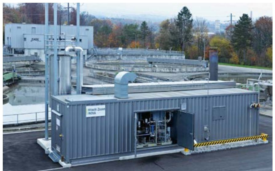
Die Biogasaufbereitungsanlagen von HZI BioMethan nutzen platzsparende Containerlösungen. Europaweit hat das Unternehmen über 70 Referenzprojekte realisiert. Im Bild: Anlage in Zuchwil SO.
