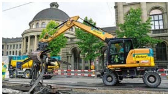
Verlad rückgebauter Schienen. (Bild: Urs Peyer)
