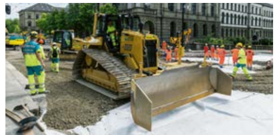
Mit zwei Dozern wurde die neue Foundationsschicht verteilt. (Bild: Peter Moser)
