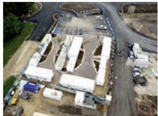
▼ Im separaten EMSolutions-Kontrollraum auf der Baustelle wird der Maschinenzustand in Echtzeit überwacht
