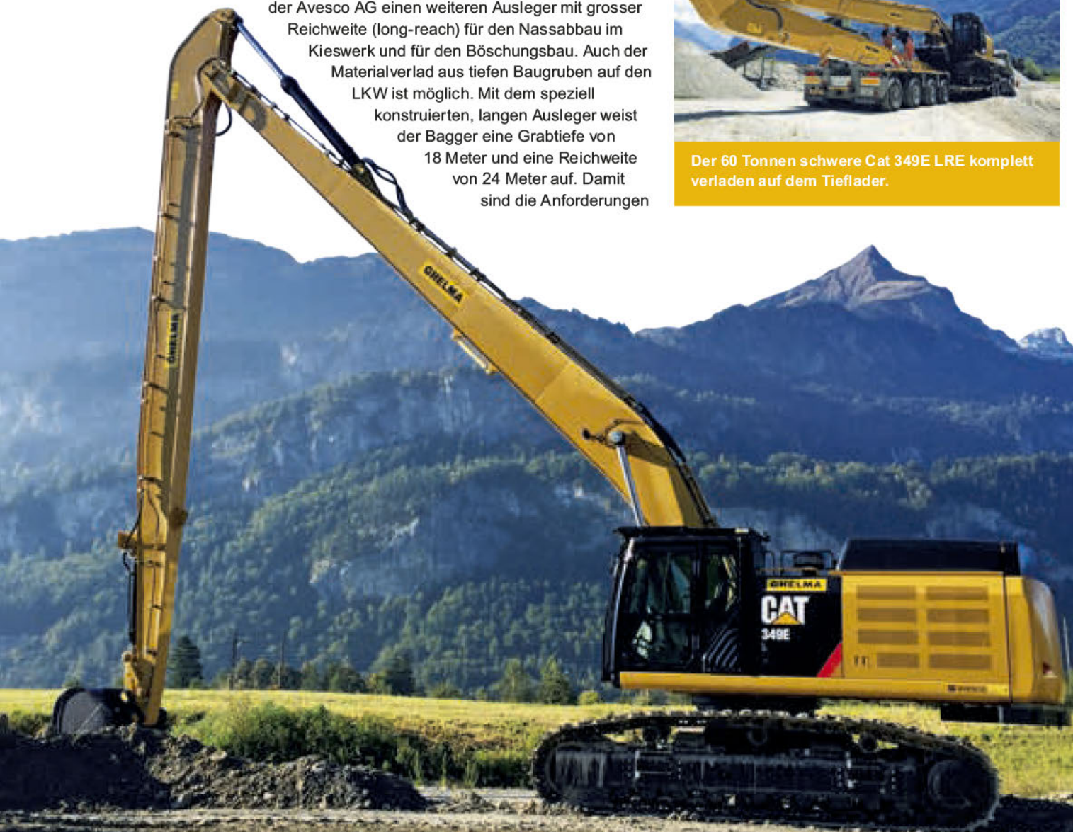
Der Cat 349E mit der long-reach-Ausrüstung im Kieswerk im Einsatz.
