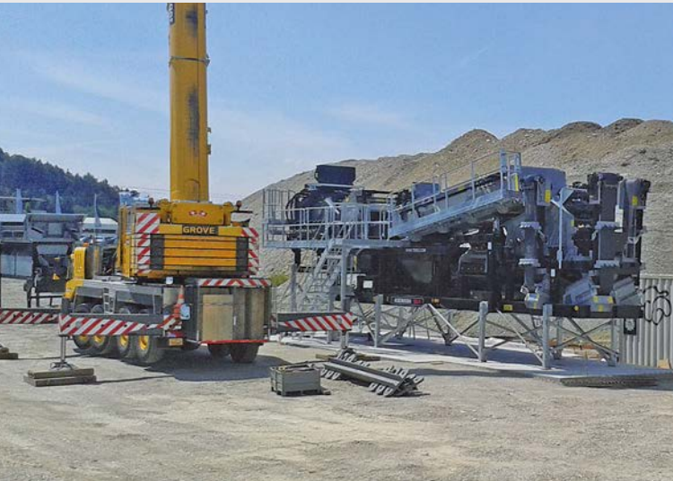
Montage de l'installation semi-mobile
