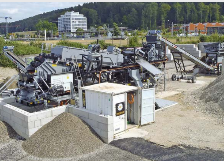
Installation en production
